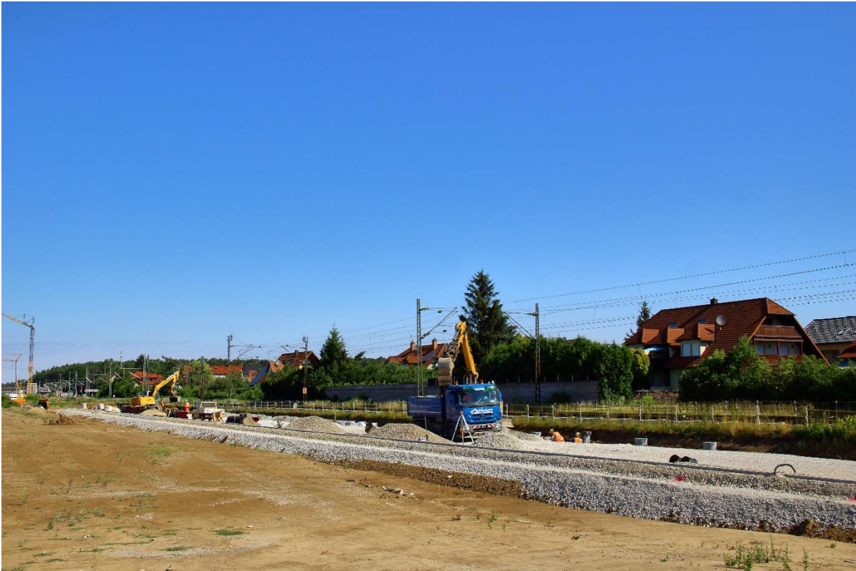
Streckenbau im Bereich Strullendorf (Bild: DB AG).
